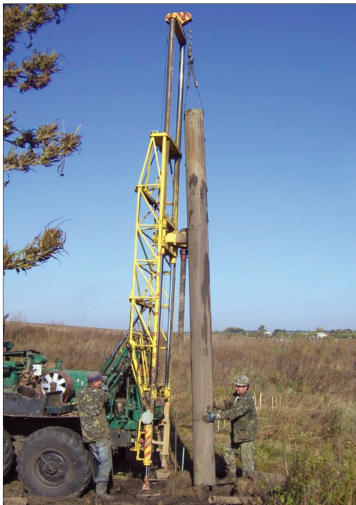
Рис. 7.5. Спорудження проникного реакційного бар'єра, м. Жовті Води
